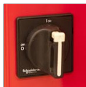
Wyłącznik elektryczny Lock-Out
